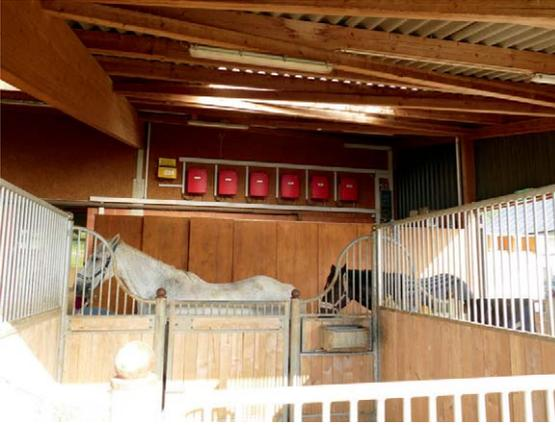
Abb. 3.7-6: Wechselrichter in einem Reitstall (=feuergefährdete Betriebsstätte), noch dazu auf einem Holzgrund installiert, Quelle: SV Schröder
