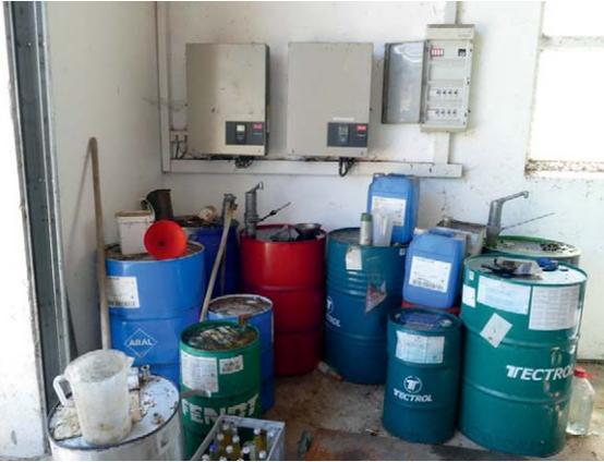
Abb. 3.7-4: Nicht erlaubter Betrieb in Räumen mit gelagerten Schmier- und Betriebsstoffen, Quelle: SV Schröder
