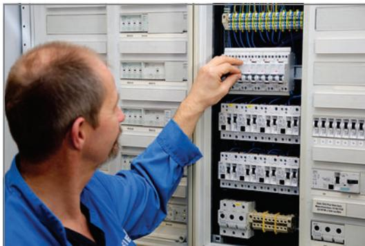
Bild 1: Verteilerschrank einer Elektroinstallation mit Schutzschaltern
