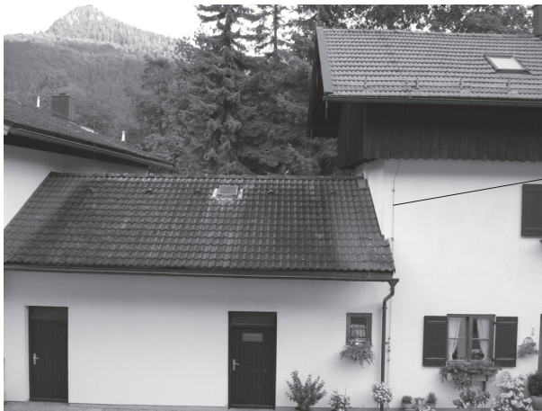
äußerer Blitzschutz am Wohngebäude
